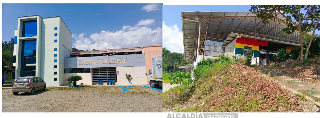
Figura 104 Equipamiento, izq. Camal, derecha. Cancha cubierta, Chimbuzá, Yantzaza.
