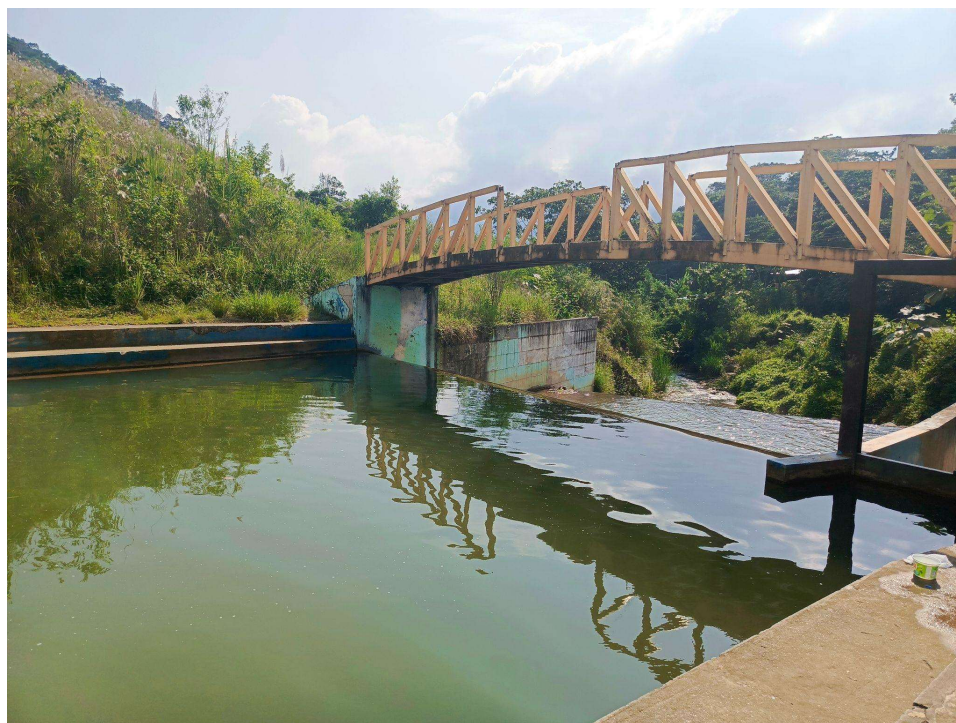
Figura 119 Estación de tratamiento de agua, Yantzaza
