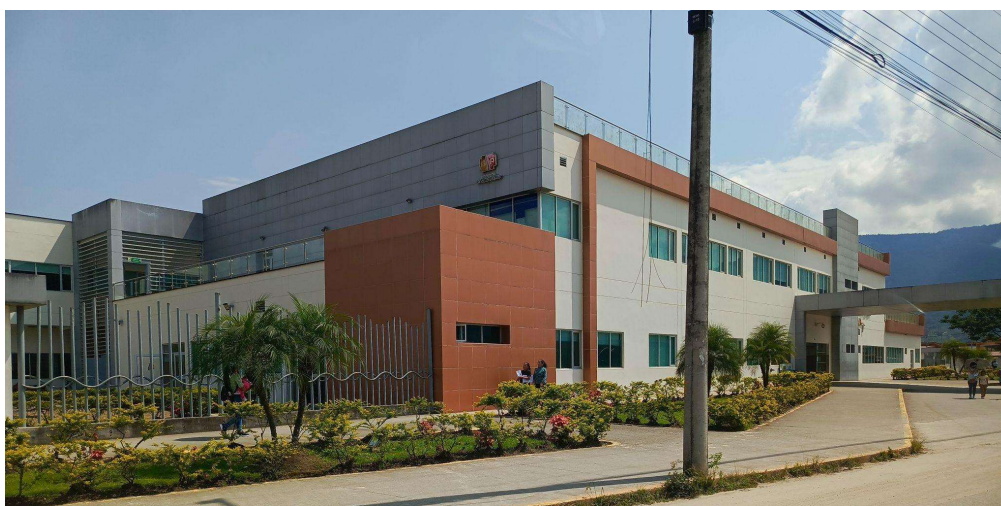
Figura 106 Equipamiento Izq. Hospital Basico, Yantzaza.
