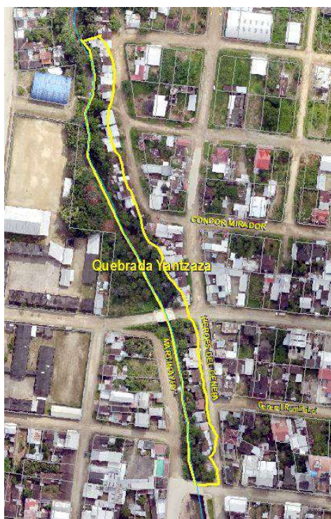
Figura 86. Asentamiento en las márgenes de la Quebrada Yantzaza
